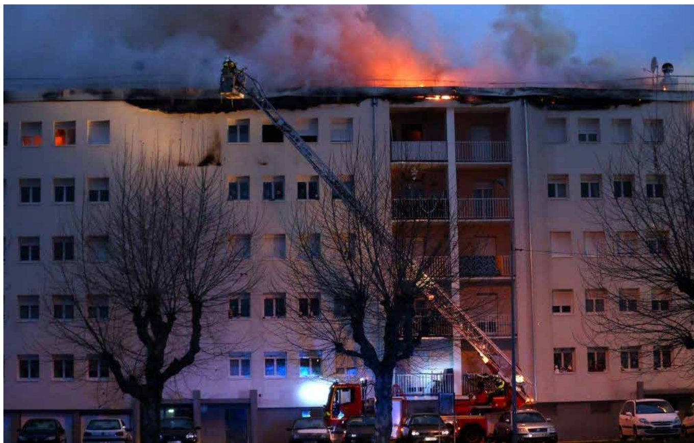
Propagation par les matériaux isolants extérieurs
